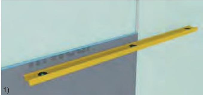
IT - Dopo aver pulito la parete, allineare il pannello al pannello di cartongesso utilizzando una livella a bolla d'aria.
