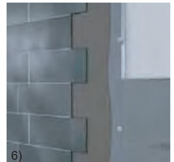
IT - Applicare sulle giunzioni dei pannelli il nastro di armatura autoadesivo.
